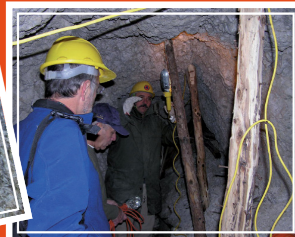
Lavori in galleria sul Sass di Stria
