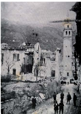
Foto di Via Garibaldi a Valdobbiadene come la trovarono gli Alpini del "Bassano" che, per primi, il 28 ottobre 1918 giunsero in piazza.
